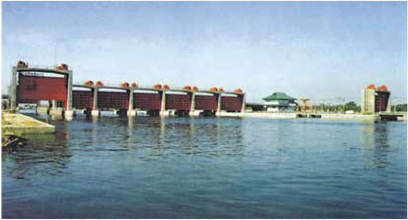
โครงการแก้มลิงฝั่งตะวันตก
